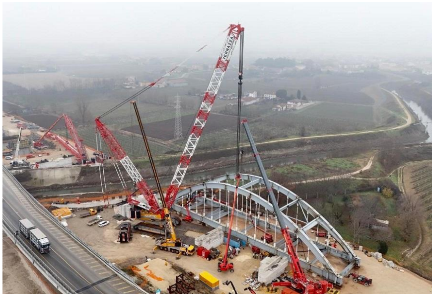
Figura 295. – Sollevamento del nuovo ponte ferroviario a San Bonifacio, in provincia di Verona (dicembre 2024)
