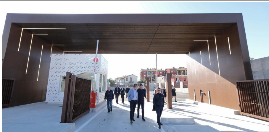
Figura 312. - Il nuovo ingresso Scaligero di Veronafiere
