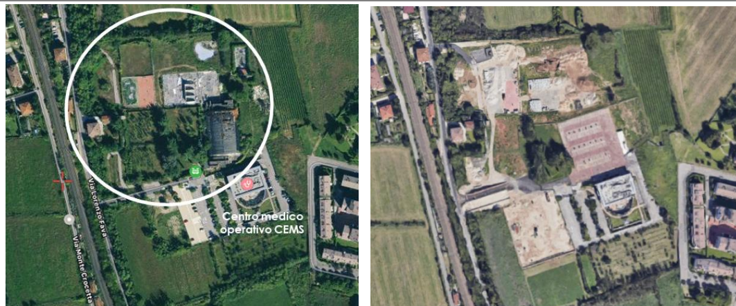
Figura 321. - Vista aerea dell'area ex Couver nel 2021 (a sinistra) e nel 2025 (a destra)
