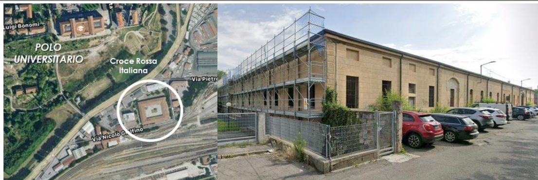
Figura 318. - Cittadella universitaria nell'ex Croce Rossa Italiana – lavori in corso (giugno 2025)
